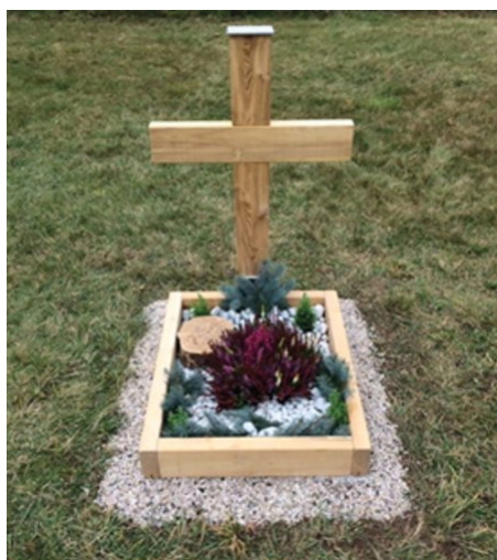
Abb. 2: Das Christkreuz, dargestellt 2022 auf dem Friedhof in Gadegast. Zwischen dem Kantholzrahmen und dem Boden besteht ein ca. 5 cm hoher, luftdurchlässiger Freiraum, der aus optischen Gründen mit Grobkieseln verblendet wurde. So kann einerseits keine Staunässe aus dem Boden das Holz berühren und andererseits Regenwasser schnell abtrocknen.
