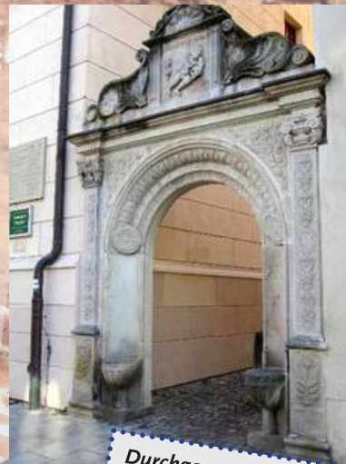
Durchgang zum Hof
